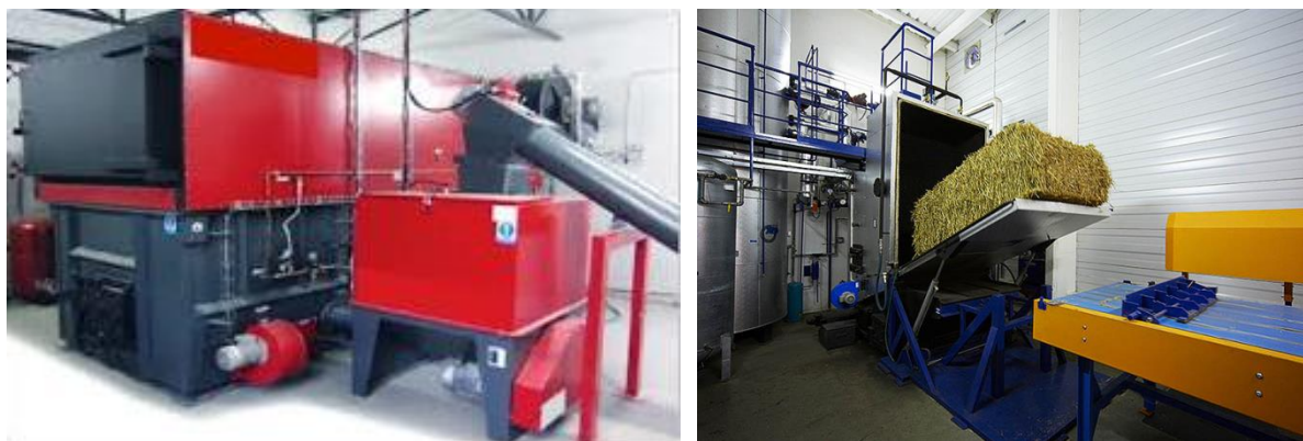
Obrázek 40: Kotle středního výkonu na spalování štěpky a slámy
