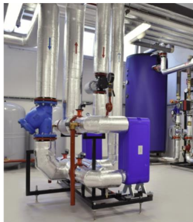
Obrázek 62: Předávací a odběratelské stanice tepla ze SZTE
