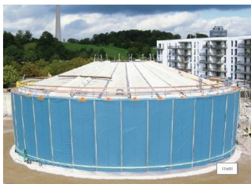
Obrázek 54: Možné provedení statických akumulátorů tepla
