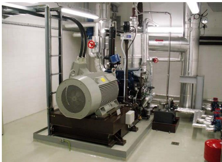
Obrázek 46: Točivá redukce páry
