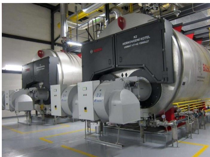
Obrázek 37: Typové provedení středních horkovodních kotlů na zemní plyn
