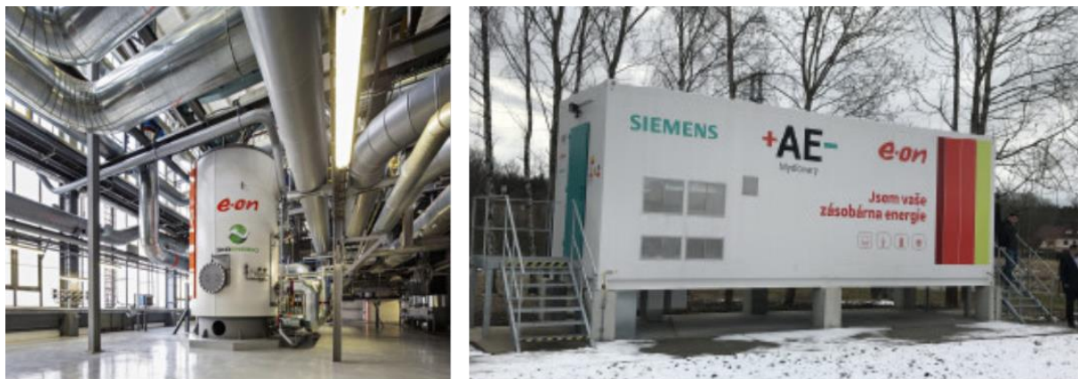
Obrázek 52: Velký elektrokotel v teplotně a bateriové úložiště elektřiny
