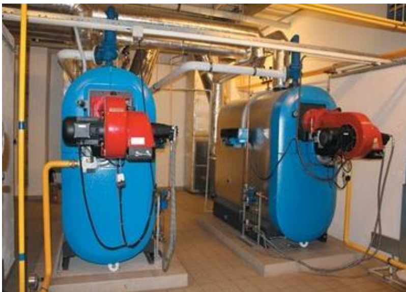
Obrázek 38: Typové provedení menších kondenzačních kotlů na zemní plyn
